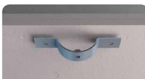
1. Fixe a abraçadeira com um parafuso na bucha previamente aplicada e aperte o parafuso com uma chave de parafusos
